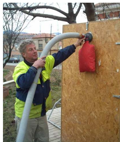
cellulosa: 0,040 W/m·K (10% Borato di sodio, ignifugo e fungicida)
