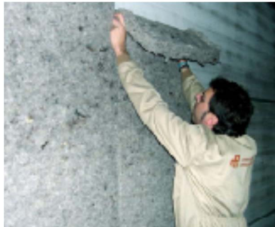
Lana di pecora: 0,043 W/m·K (12% fibra di poliestere)
