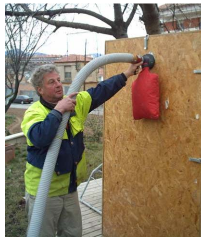
Celuloza: 0,040 W/m·K (10% Boraks, ochrona przed ogniem i środek grzybobójczy)
