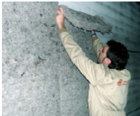
Lana de oveja: 0,043 W/m·K (12% fibra de poliester)
