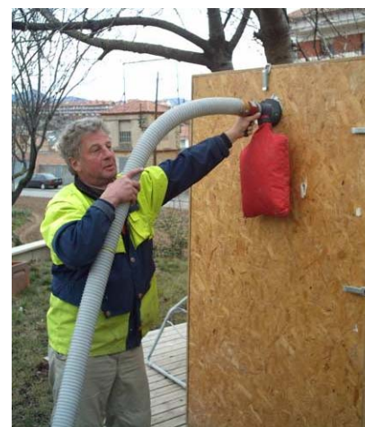
Celulosa: 0,040 W/m·K (10% Bórax, protección ignífuga y fungicida)
